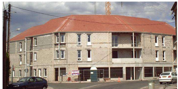
Figure 6 Etat du chantier au 29.08.03
